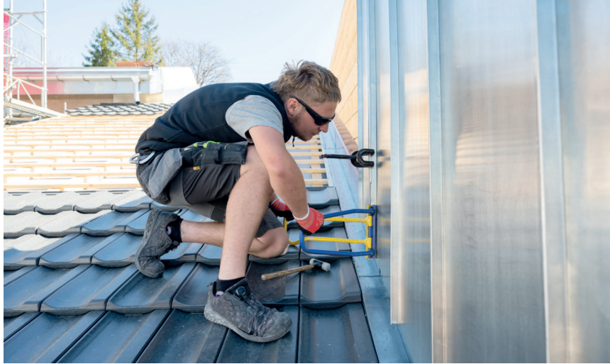
◀ Adrian de Graaff met en place les joues de lucarne qu'il a fabriquées quelques jours plus tôt à l'atelier.
